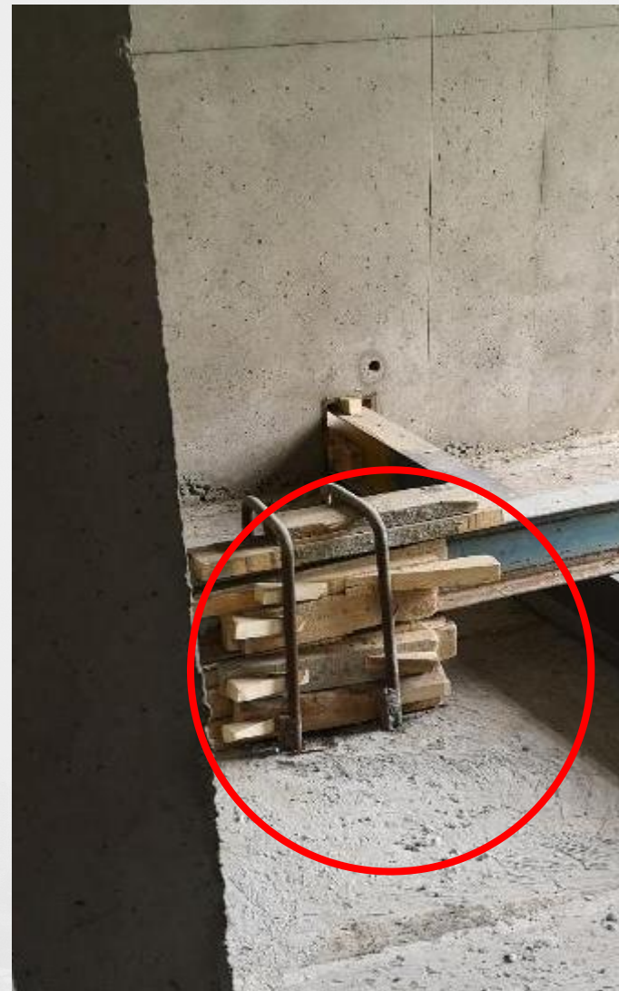
悬挑梁锚固段焊接
