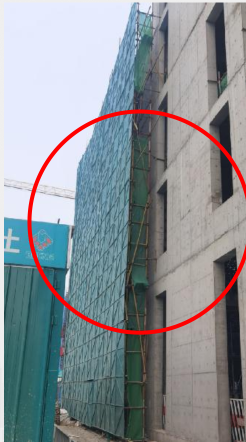
连墙件缺失，开口架未搭设之字斜撑
