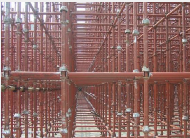
碗扣式钢管脚手架
