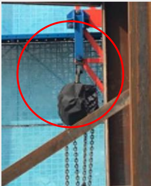
传感器安装位置不合理，同步控制装置损坏
