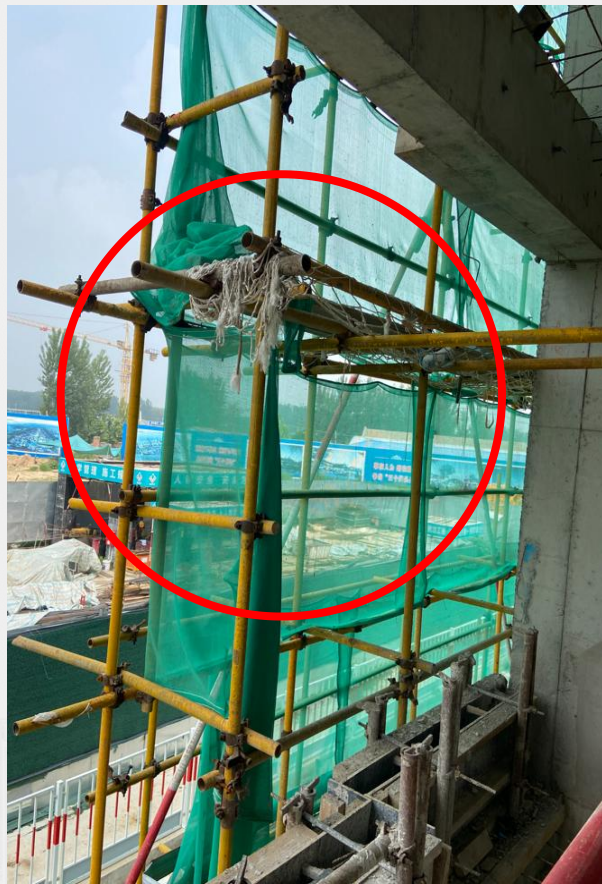
连墙件缺失，开口架未搭设之字斜撑
