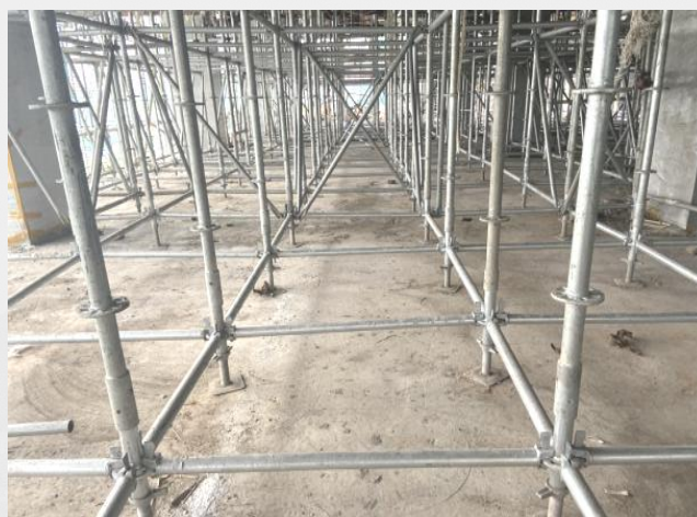
承插型盘扣式钢管支架
